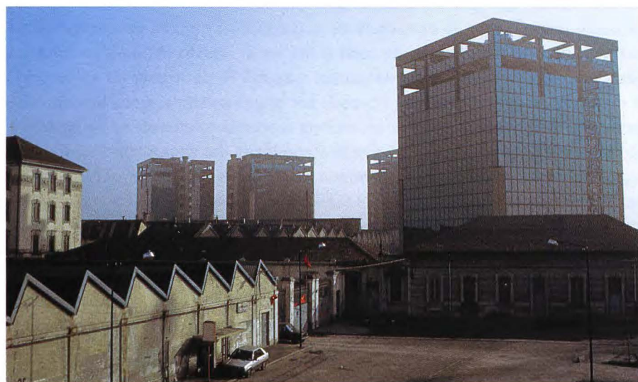
Fig. 3. Antiguas naves de la firma Richard Ginori, en Milán, cerca de las torres para oficinas construidas en la misma área por el Grupo Ligresti (proyecto Elvetia Engineering, srl).
